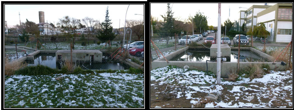
Figura 5 Lados norte y este del estanque de H 2 A o .
