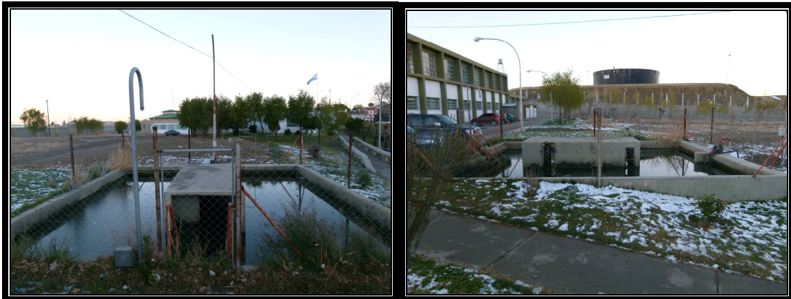
Figura 6 Lados Norte y Oeste del estanque de H 2 A o
