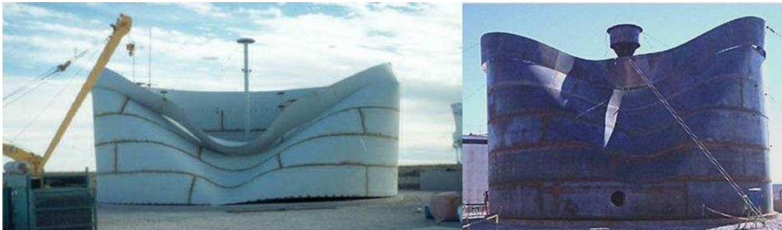
Figura 1: fotografías de dos tanques de petróleo en construcción en el norte de la Patagonia, que colapsaron a velocidades del viento muy inferior a las de diseño.
