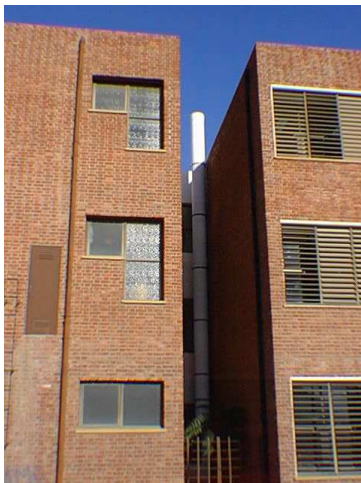
Figura 4: vista exterior de la Torre de Caída Libre de la FI-UNComahue, en Neuquén
