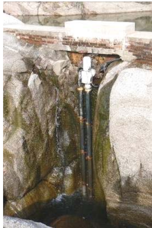
Figura 3. a) Picoturbina construida.
