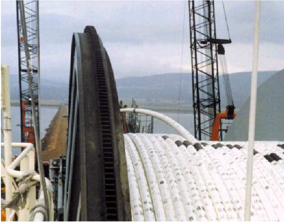
Fig. 9 – Operación de tendido offshore de linepipe a partir de una bobina.
