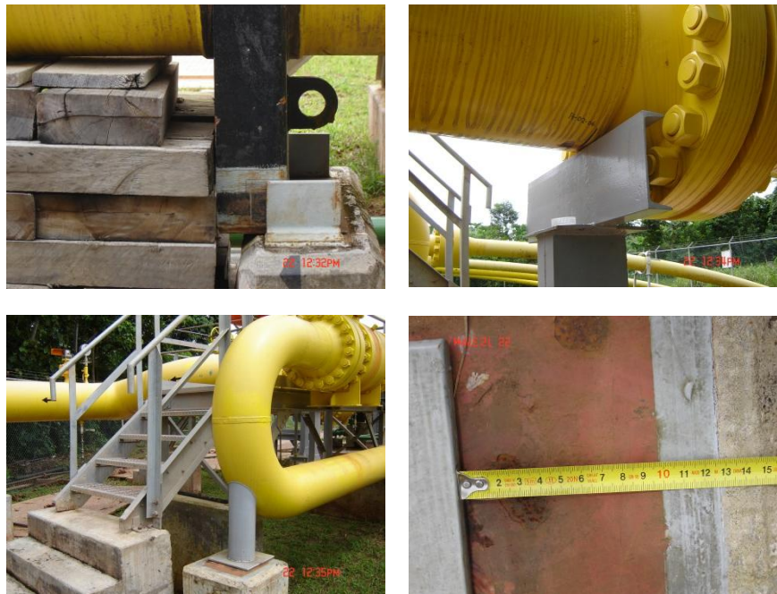
Figura 6 Desplazamientos en Trampa de Scraper de Ø20"
