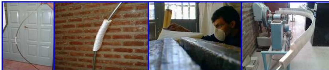
Figura 6: fotografías que muestran las distintas etapas de construcción de las palas.
