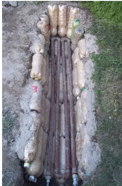
Figura 6. Disposición de las botellas rellenas con viruta formando el aislamiento térmico y serpentín calefactor.
