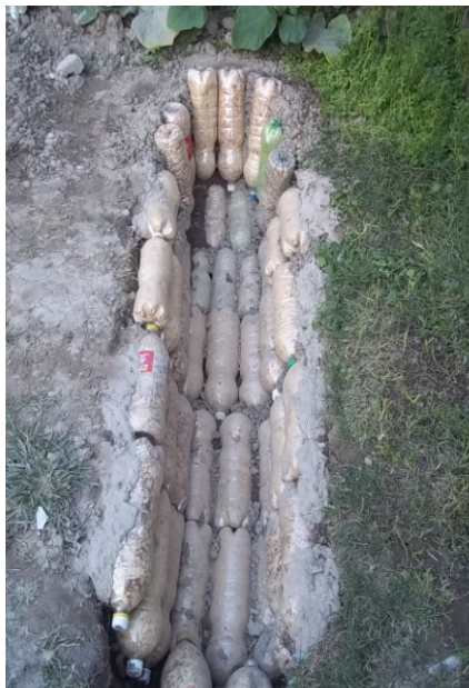
Figura 6. Disposición de las botellas rellenas con viruta formando el aislamiento térmico y serpentín calefactor.
