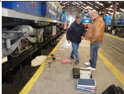
Figura 9. Instalación del segundo prototipo en la locomotora.
