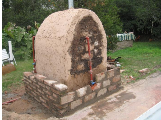
Figura 7. Construcción del sistema aislante de doble pared
