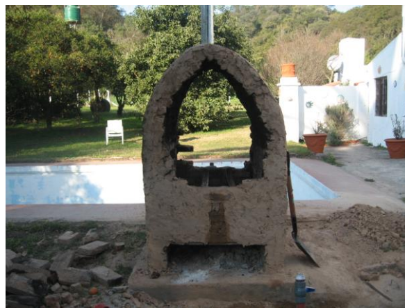
Figura 6. Cámara de combustión y cuerpo de la caldera
