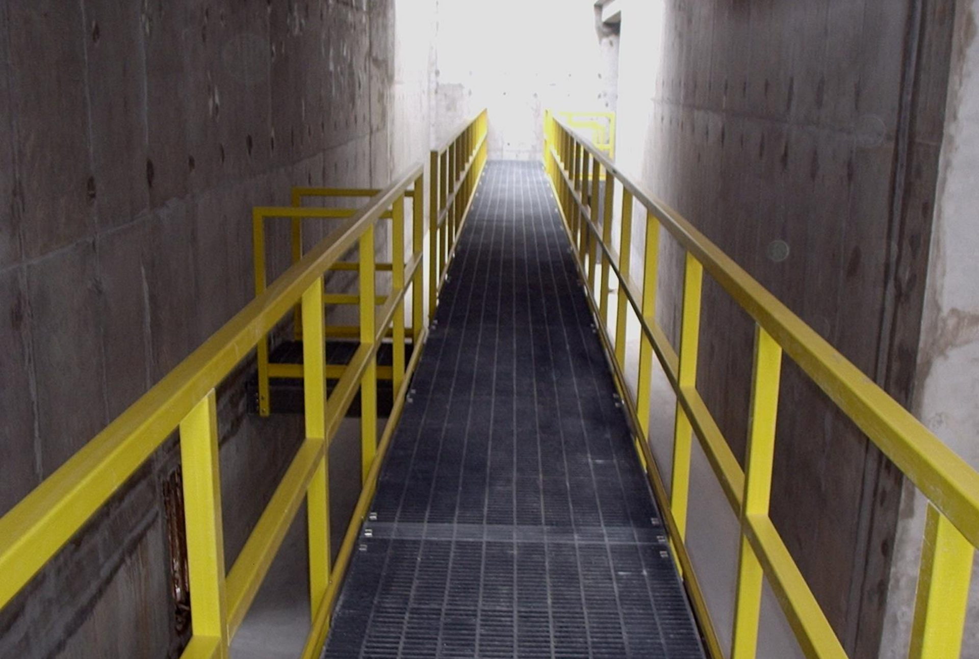
PASARELA PARA PLANTA DE TRATAMIENTO DE AGUAS - AYSA
