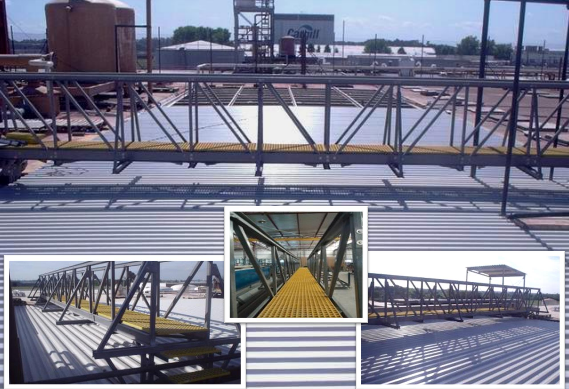
PASARELAS SOBRE GALPÓN Y CHAPAS - TRANSCOLOR
